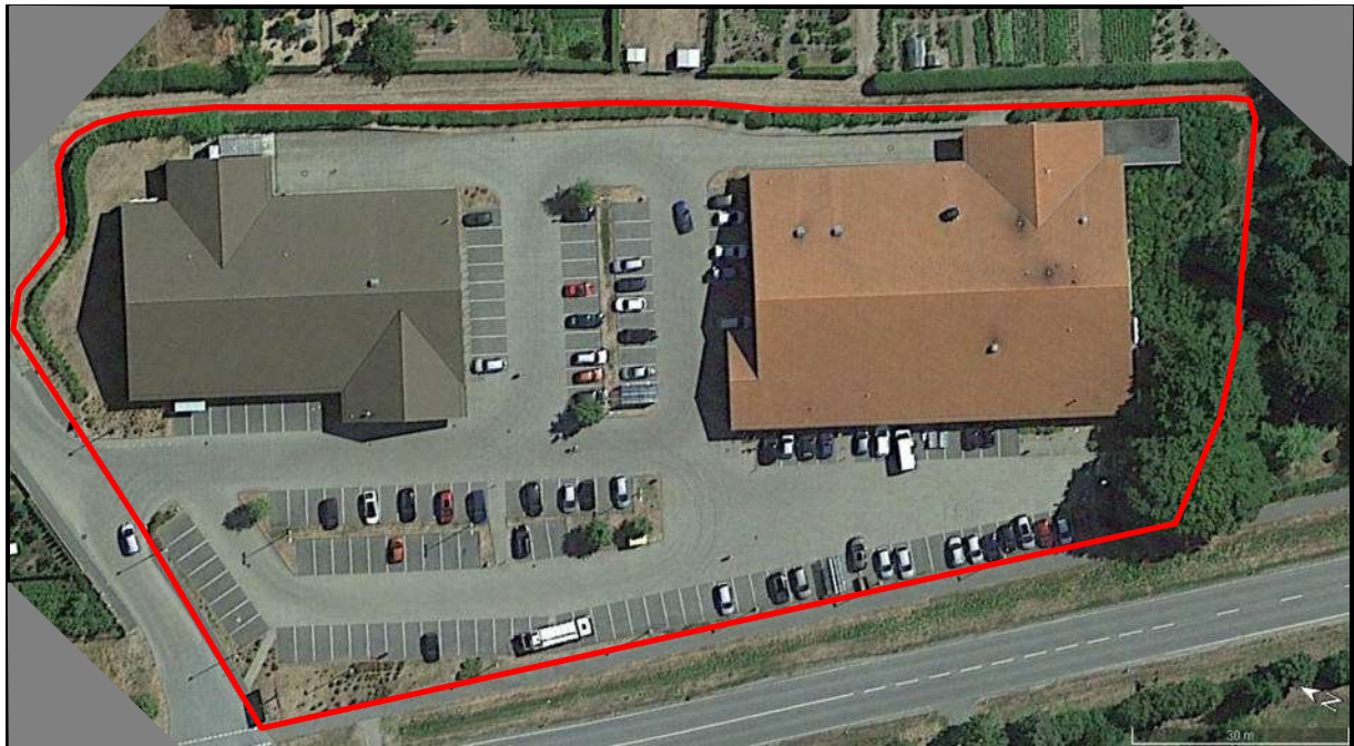
Abb.1: Der aktuelle Gebäudebestand mit den Markthallen Aldi (links) und Edeka (rechts) mit dem derzeitigen Parkraumumfeld sowie der Grundstücksgrenzbepflanzung (rot = Grenze Untersuchungsraum)
