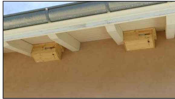
Abb. 17: Nisthilfen für Mauersegler an der Längsseite eines Gebäudes unter dem Dachüberstand (Quelle: Vogelwarte.ch)
